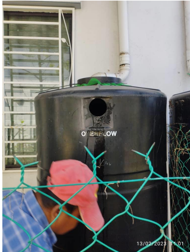
Rajah 22: Menunjukkan technician professional melakukan penyelenggaraan sistem SPAH
