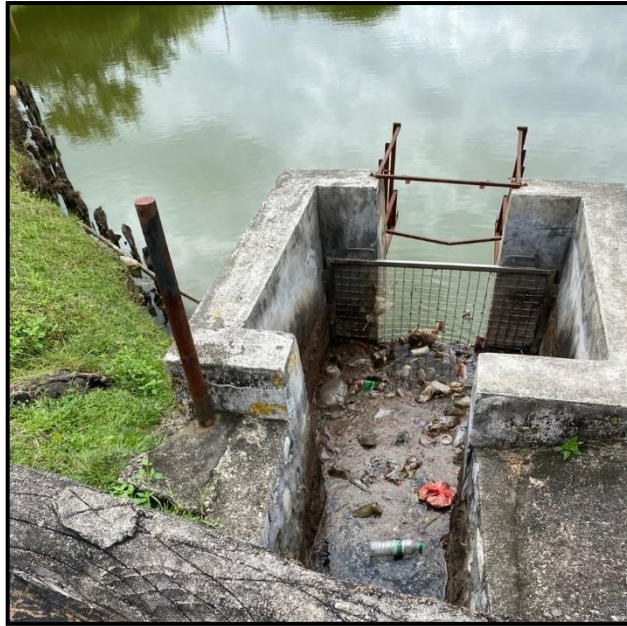
Rajah 8 Perangkap Sampah Jenis Skrin, Di Politeknik Sultan Salahuddin Abdul Aziz Shah, Shah Alam, Selangor
