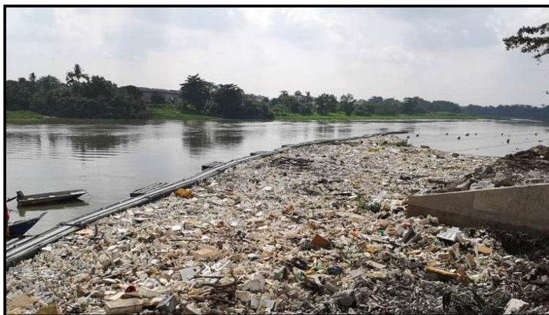
Rajah 6 Perangkap Sampah Jenis ' Boom Trash ' Di Sungai Kandis, Malaysia
