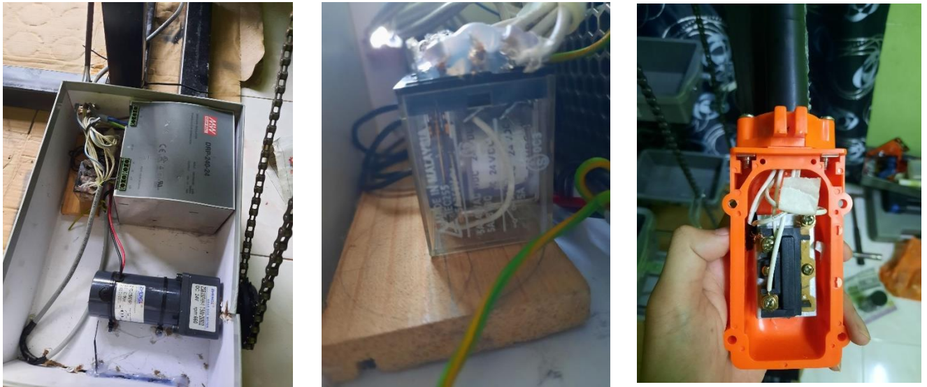
Rajah 3.19 Pemasangan Wayaring pada Alatan Pusingan Simpanan.
