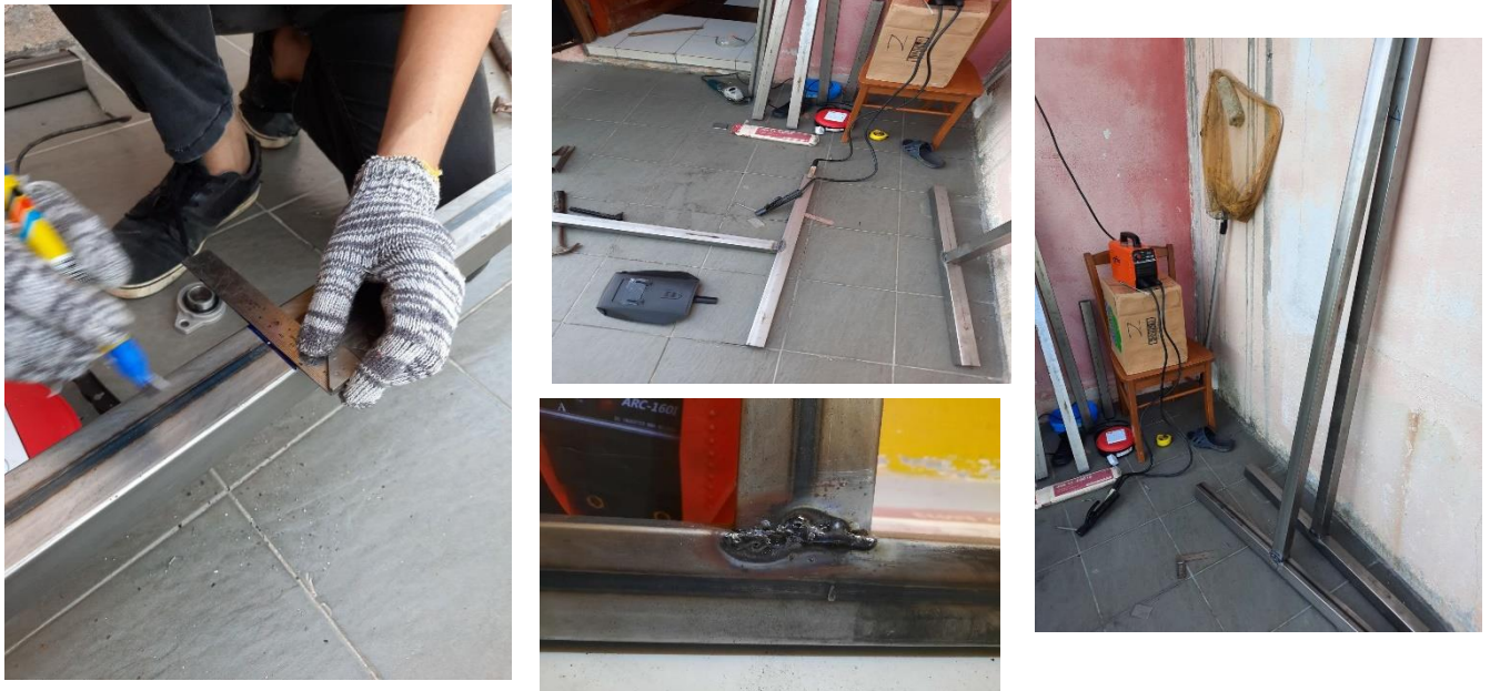
Rajah 3.12: Pengukuran, pemotongan dan mengimpal besi hollow
